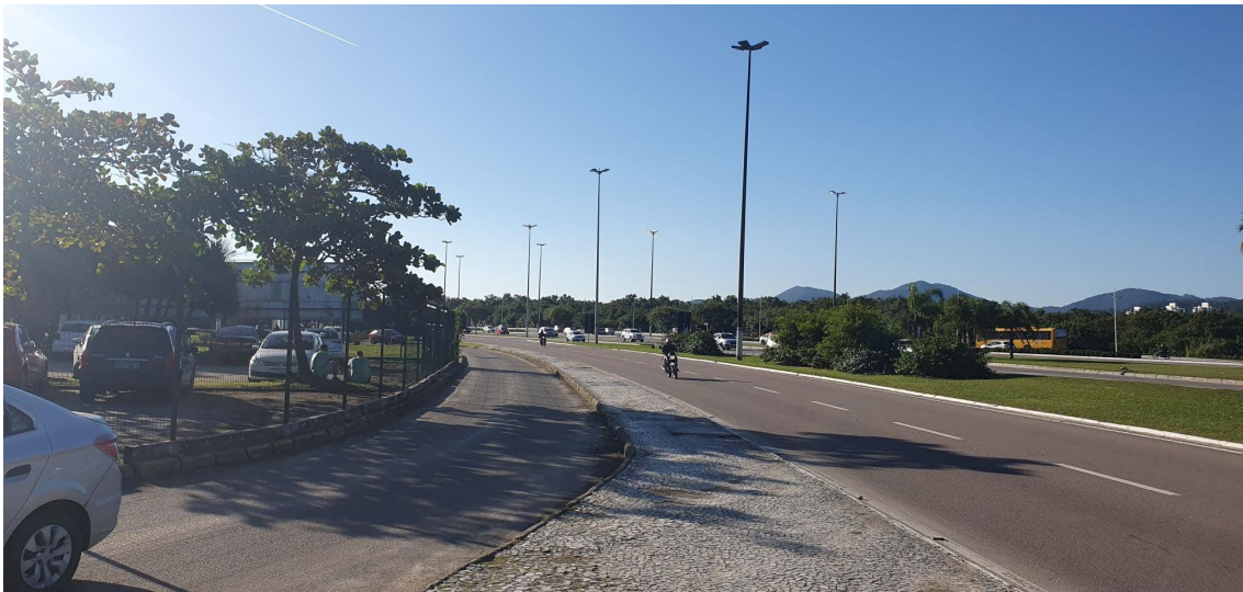
Foto 10 – Trecho do estacionamento previsto de ser afetado pela implantação do elevado
