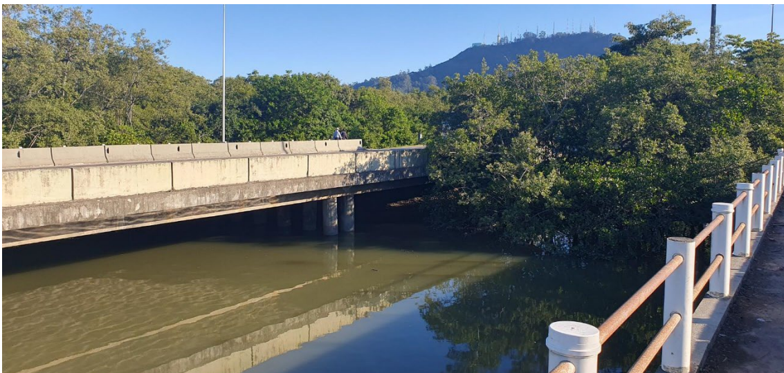
Foto 11 – Ponte sobre o rio Sertões que será alargada
